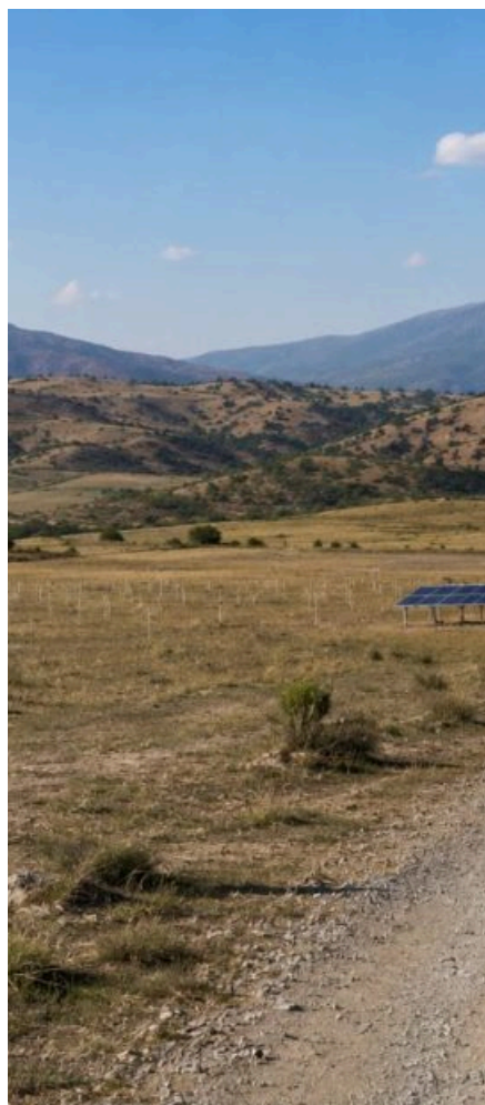
ENERGY · 109 MWP, VELES
